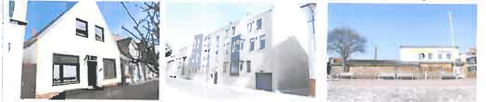
Untypische 70er Jahre Einfamilienhaustypologie in der Mühlenstrasse. Der gelbe Fassadenputz verstärkt diese negative Wirkung.
