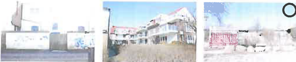
Das Kulturdenkmal besonderer Bedeutung im Schnittgang ist nicht in Wert gesetzt. Die Optik der Hofmauer ist bezeichnend für die Herabstufung der historischen Gasse zur einer Rückseitenstrasse.
